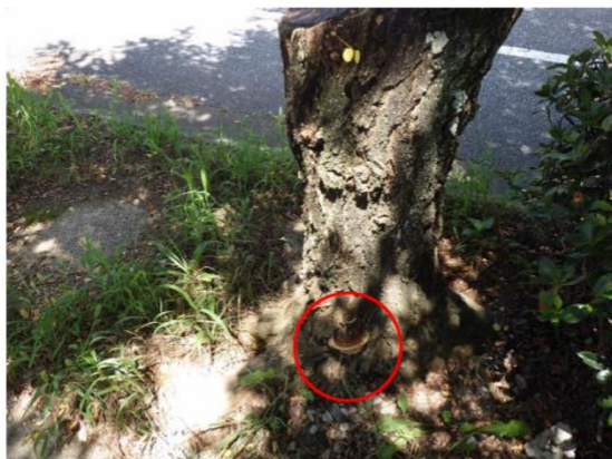
腐朽（きのこ発生）
